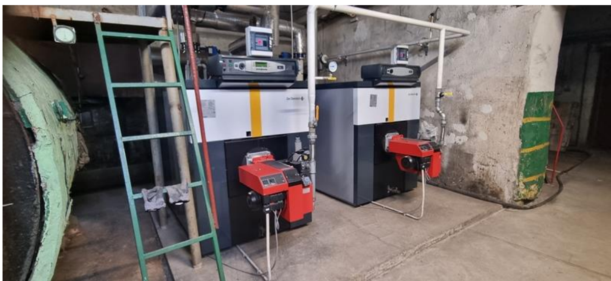
Joonis 2.3 Katlad De Dietrich põletitega Bentone
