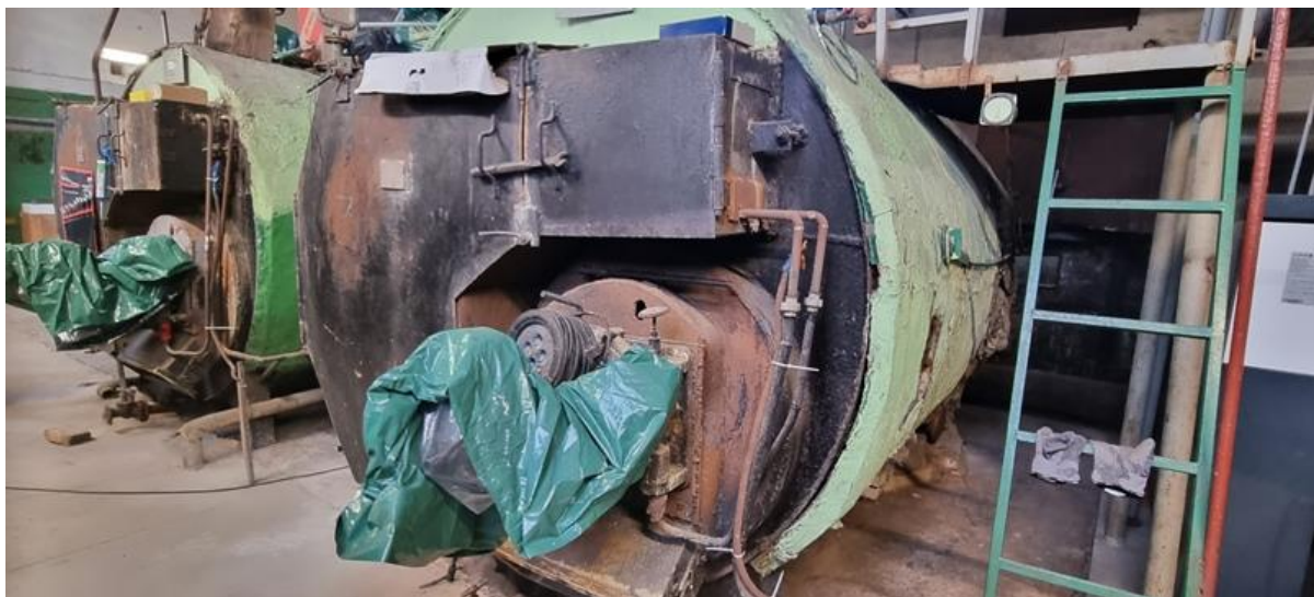
Joonis 2.2 Mittetöötavad ja süsteemist lahti ühendatud Kiviõli-80 tüüpi katlad Kukruse katlamajas
