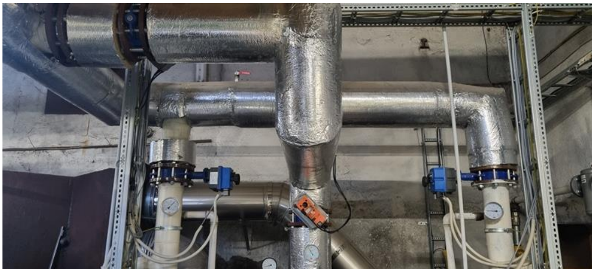
Joonis 2.4 Torustikul olevad mõõteriistad ja reguleeriseadmed
