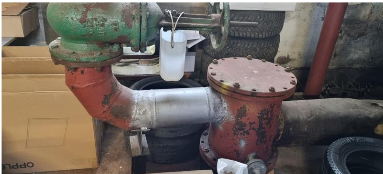
Joonis 2.8 Mudafilter ja suur ventiil tagastuva vee torul
