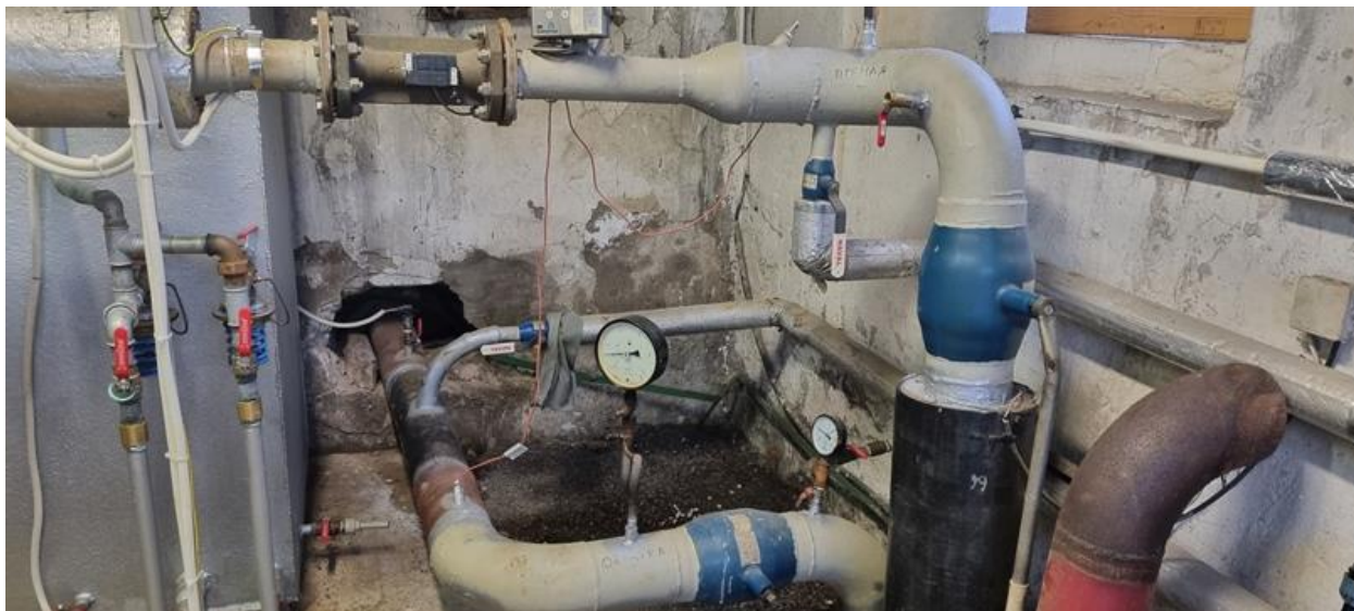
Joonis 2.7 Katlamajast väljuva ja tagastuva küttevee torud
